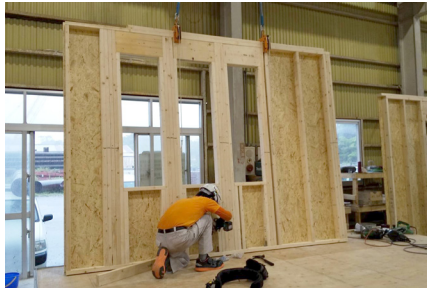
雨に濡らさないようパネル化で現場作業を減らす
