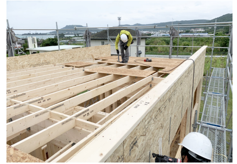
雨に濡らさないようパネル化で現場作業を減らす
