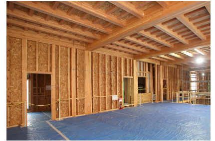
カナダ・ストラクチュラム社の大断面集成材とカナダ産 OSB の耐力壁で構成した、大規模木造のシティフォレスト宮城野ビル
