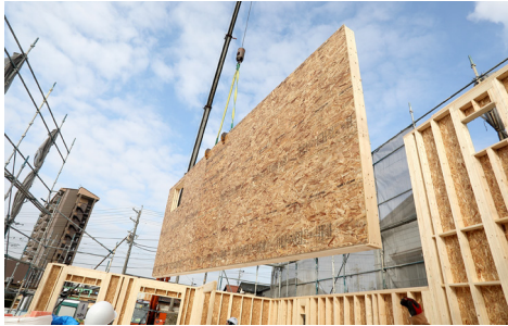
カナダ産 OSB を壁に使用したバレエスタジオの事例。開放感のある空間を 2 × 4 工法で実現
