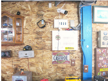
厚みと強度がある OSB は、施工後に様々な物を取り付けられるので使い勝手がいい
