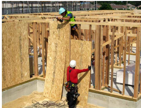
釘がめり込む過ぎないように注意しながら現場で3×8サイズのカナダ産 OSB を張る
