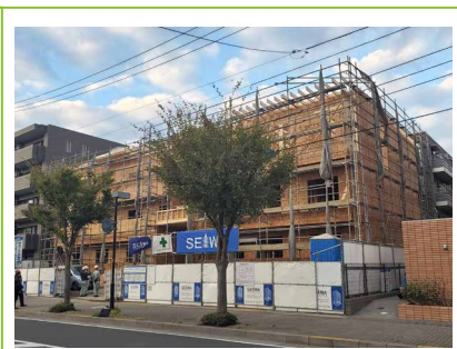
木三共 (生和コーポレーション)
