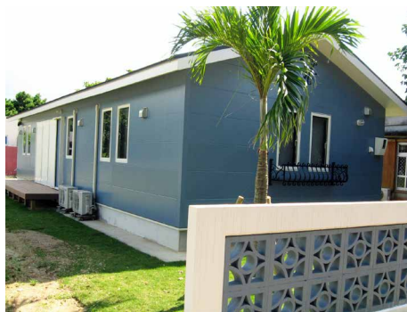
建築主の希望に沿って調色・塗装したこだわりの外壁と、沖縄伝統の花ブロック
