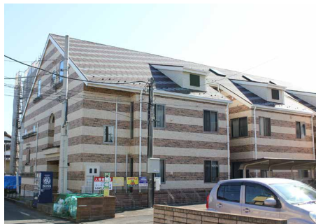
隣接する既存建物は 3 階建ての木造耐火建築物
