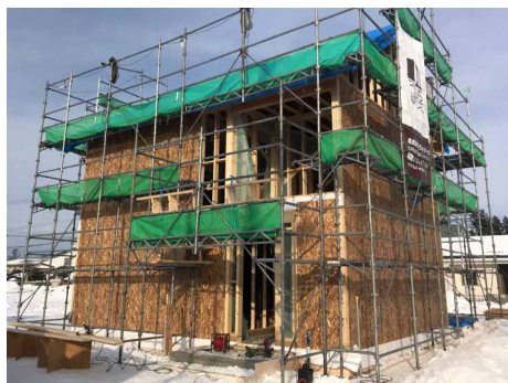
外壁の面材として長尺のカナダ産 OSB を施工
