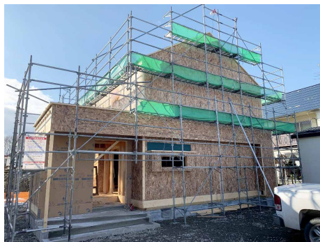
2×4 工法を採用し、外壁にカナダ産 OSB を張ることで、精度が高い住宅を実現する
