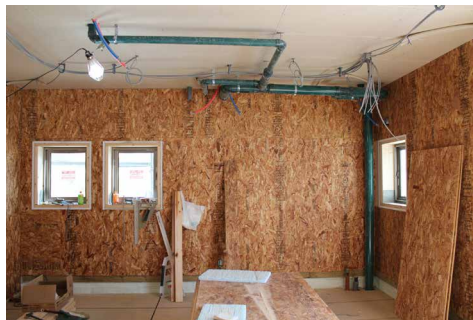
カナダ産 OSB を利用した耐力壁を施工
