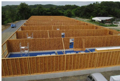
26m x 76m の畜舎を 2 x 4 工法で実現する
