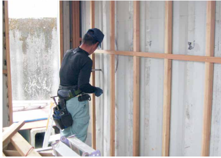
下地を組み断熱材を施工したのちに仕上げる
