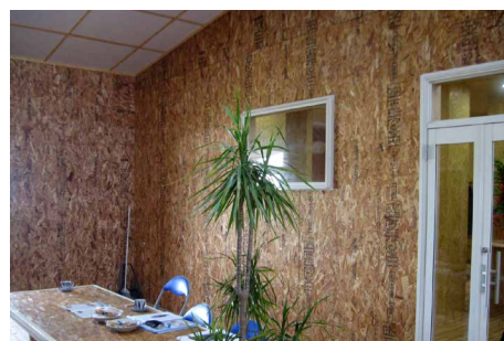
同社事務所の内装材にカナダ産 OSB を施工
