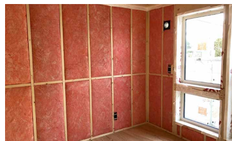
適切に施工された充填断熱のグラスウールは、十勝のビルダーの技術力を物語る
