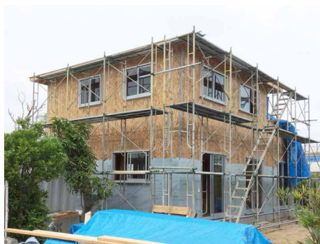
供給と価格、品質が安定したカナダ産OSBを壁に採用する
