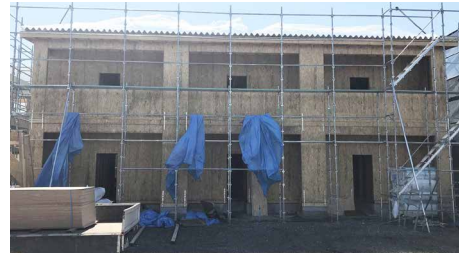
カナダ産 OSB を使い 2×4 工法のアパートを建設
