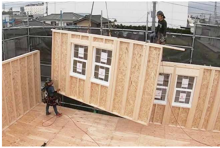
工場でサッシまで取り付けられた FBS の壁パネル
